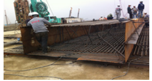
图9 现场钢筋加工
