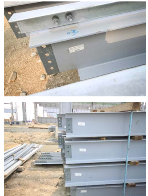
图22 现场钢结构跟踪标签
