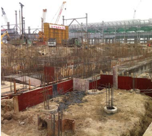
图6上 1#2#板坯连铸机基础开挖方案 图6下 1#2#板坯连铸机基础开挖现场
