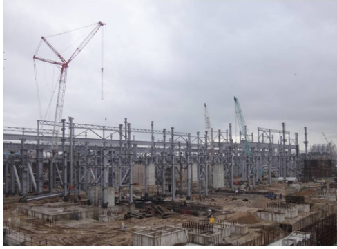
图24 现场钢结构安装
