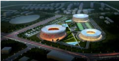
天津团泊湖网球中心——斜圆柱式的网架结构
