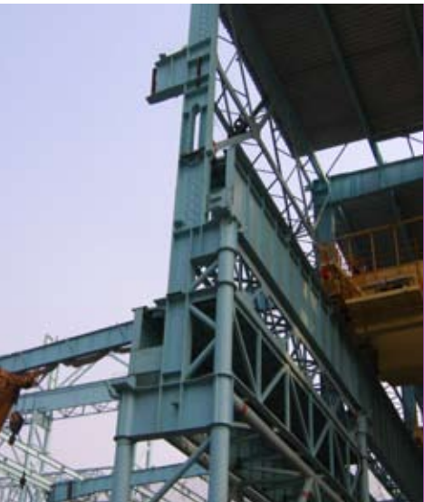
图片由宝钢工程技术集团有限公司提供。
