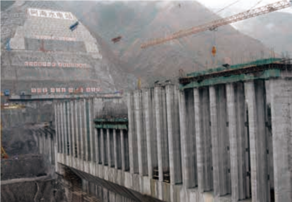
图1 施工中的阿海水电站
