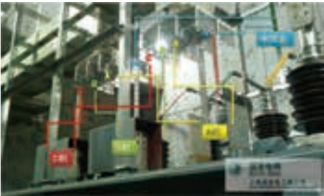
图19 现场情况照片
