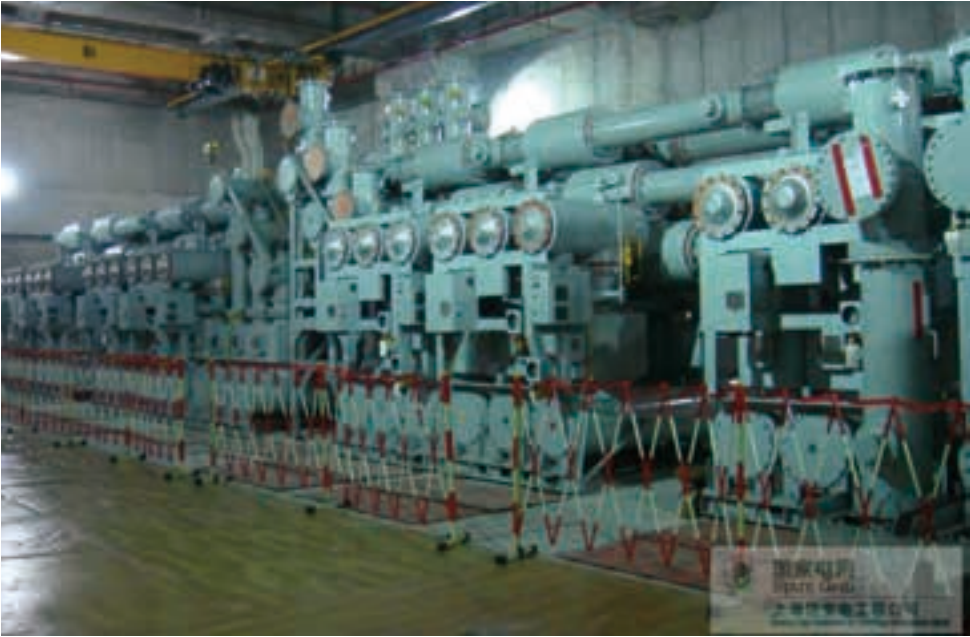
图片由上海送变电工程公司提供。
