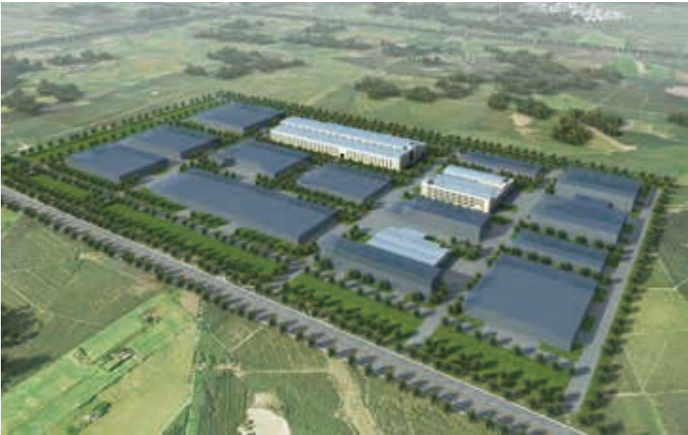
陕西秦川机械发展股份有限公司绿色恒温车间改造项目鸟瞰图
