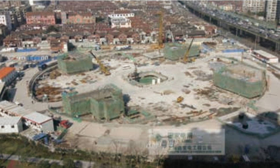
图片由上海送变电工程公司提供。
