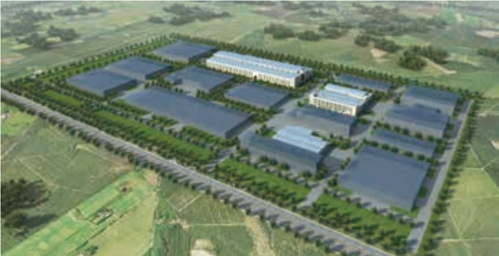
图1 陕西秦川机械发展股份有限公司恒温车间改造项目鸟瞰
