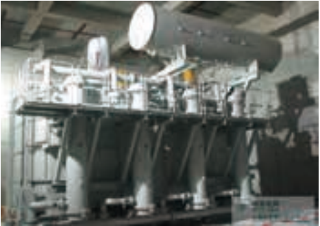
图片由上海送变电工程公司提供。
