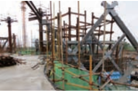
图6 施工现场照片
