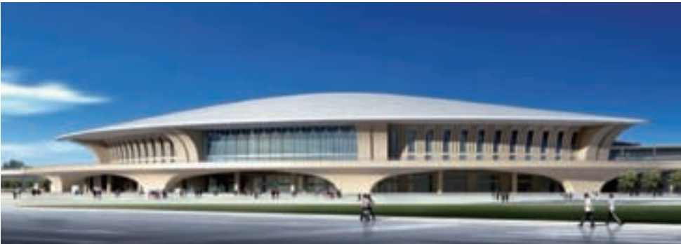
图1 乌鲁木齐高铁火车站室外透视图
