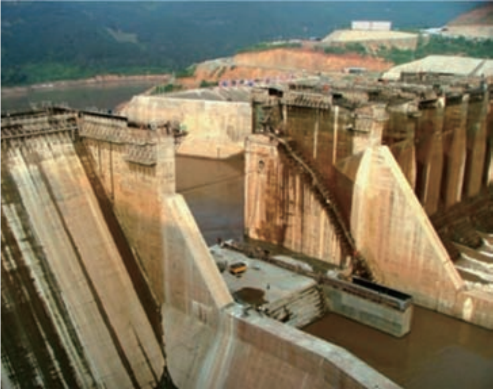
园水电站项目实景图
