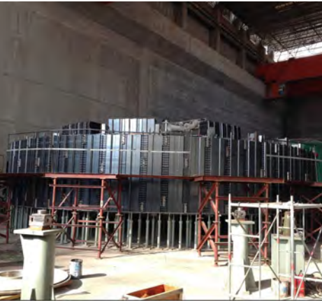
图11 最新现场施工图片
