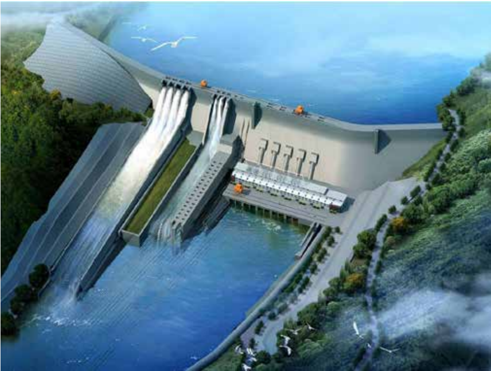
图1 观音岩水电工程枢纽布置
