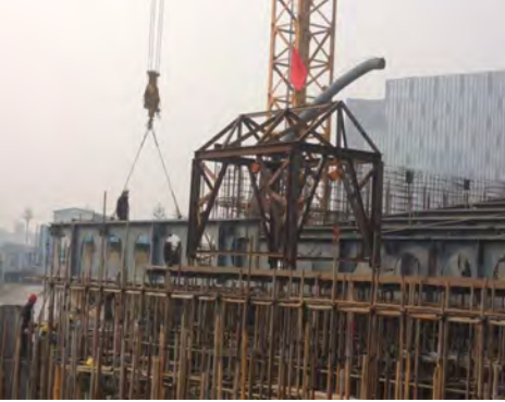
图12 钢结构滑移安装现场图片
