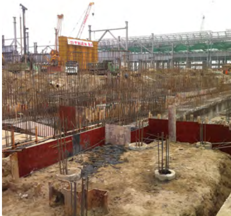
图6下 1#2#板坯连铸机基础开挖现场
