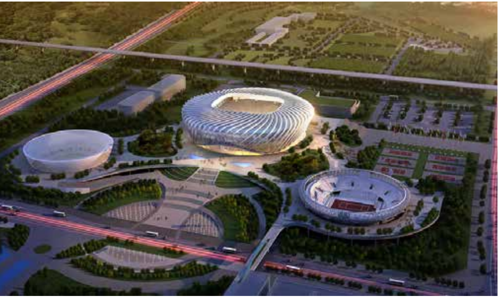
图1 光谷国际网球中心室外透视图
