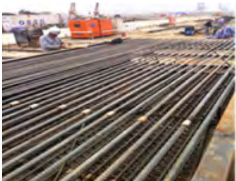
图9 现场钢筋加工
