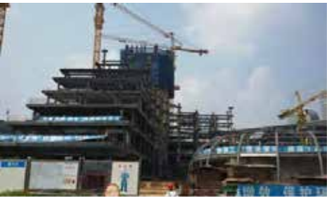
图9 施工进度模拟与实际进度对比图
