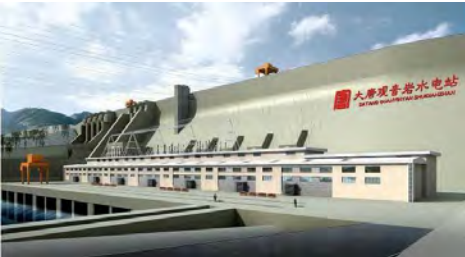
图2 观音岩水电站大坝及发电厂房
