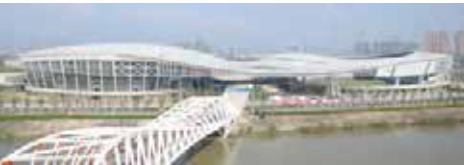
图3 现场施工过程中远景实物图
