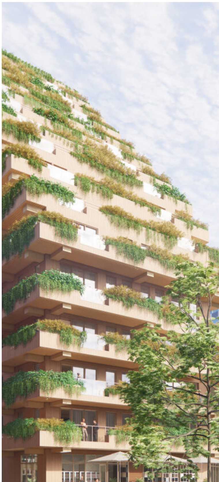
Mei architects and planners が設計した「SAWA」は、「オランダで最も健全な建物」と呼ばれる、ロッテルダム初の木造高層住宅だ。クロス ラミネイティド ティンバー (CLT) という工法が広範に適用されている。画像提供: Mei architects and planners
