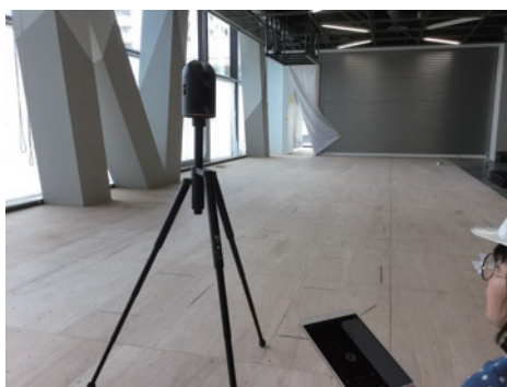
オートデスクの点群処理ソフト「ReCap」と連動する小型3Dレーザースキャナー「BLK360」で改装前の建物内部を点群計測した
