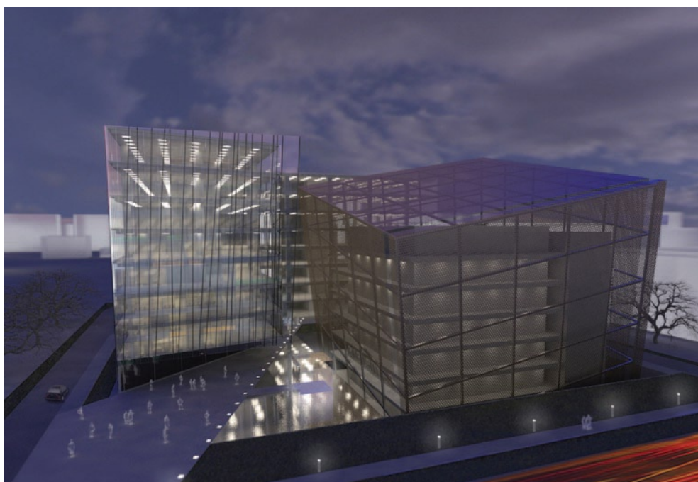
Data Center - Kompleks biurowo - usługowy wraz z Datacenter w Warszawie.
