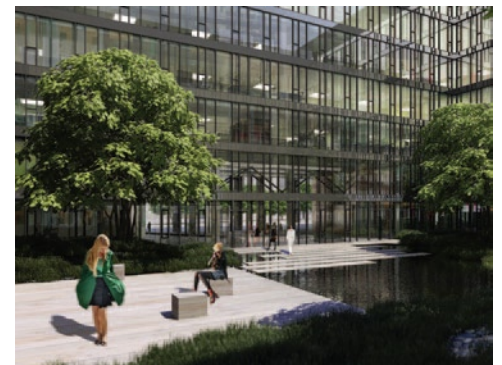
Konstruktorska Business Center - Budynek Biurowy w Warszawie. Deweloper HB Reavis.
