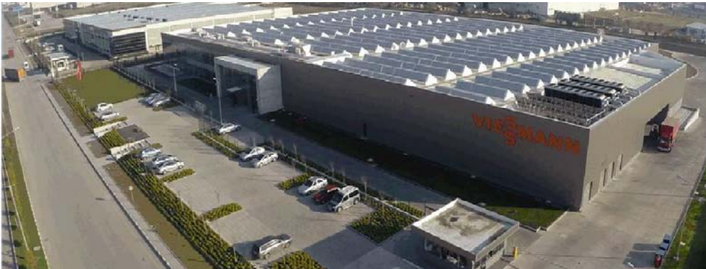
Viessmann Manisa Fabrikası Kompleks Tesis Projesi
