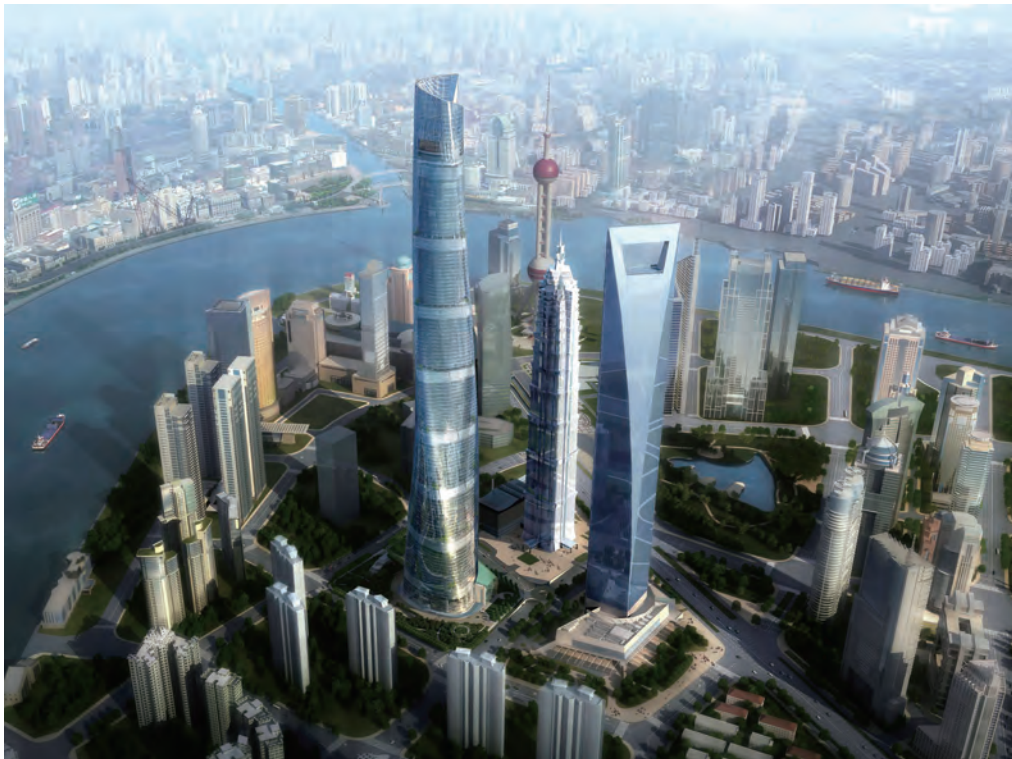
图片由上海中心大厦建设发展有限公司提供
