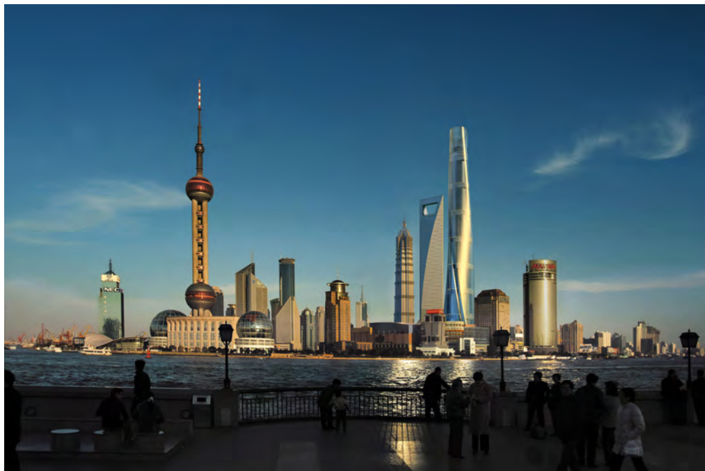
图片由上海中心大厦建设发展有限公司提供
