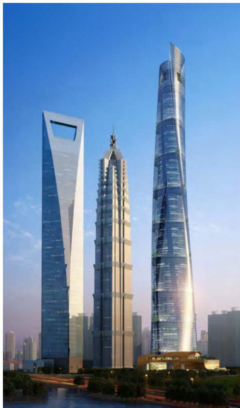
图片由上海中心大厦建设发展有限公司提供
