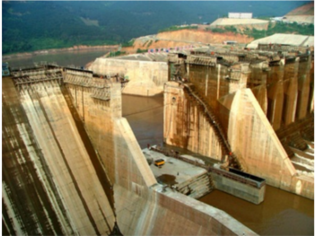
园水电站项目实景图
