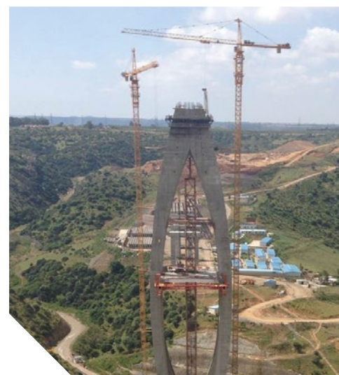
主塔の建設風景【提供：Egis JMI】
