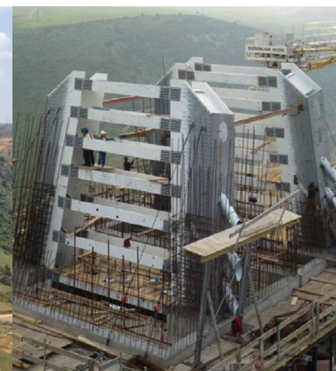
尖塔の建設【提供：Egis JMI】
