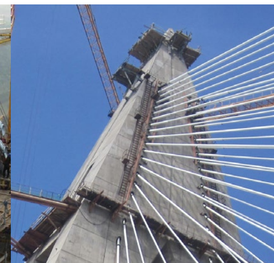
尖塔のケーブル【提供：Egis JMI】
