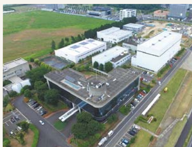
茨城県つくば市にある7万平方メートル超の技術研究所(写真:安藤ハザマ)
