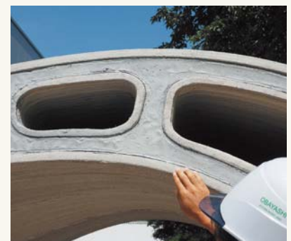
打ち込み型枠の間に充てんされた「スリムクリート」（写真：家入龍太）
