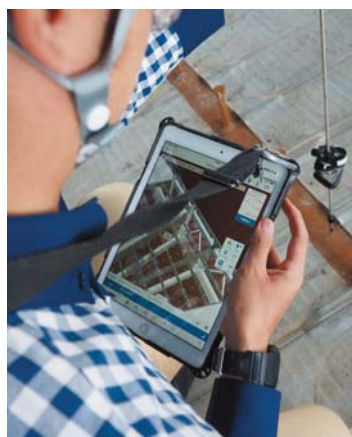
BIMモデルデータをタブレットに取り込み、1人墨出しを行った例。矢作建設工業の現場にて(左写真:家入龍太、右資料:矢作建設工業)
