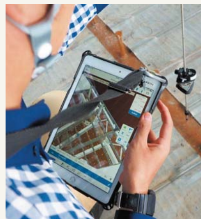
タブレットを手に持って墨出し作業を行う技術者(写真:家入龍太)
