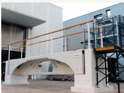
3Dプリンターで作成した人道橋(写真:大成建設)
