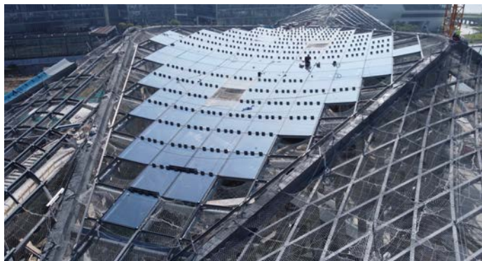
屋盖幕墙玻璃
