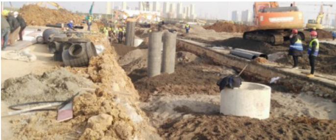
图15 室外管网现场施工图
