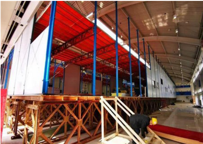
图17 医护休息改建区贝雷架基础实物图
