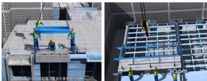
图24 预制构件吊装模拟
