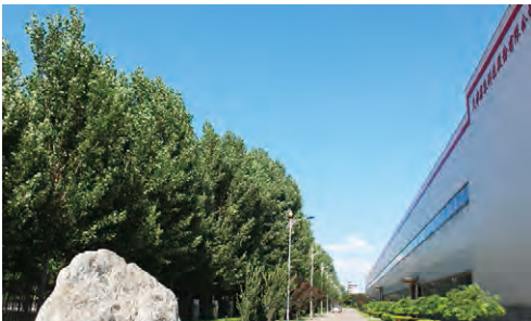
天津赛象科技股份有限公司三期厂房
