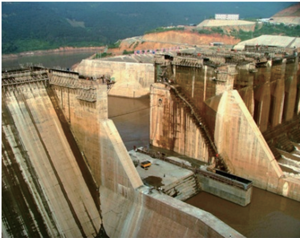
园水电站项目实景图
