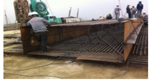
图9 现场钢筋加工
