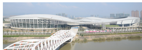
图3 现场施工过程中远景实物图
