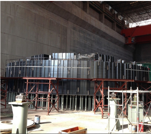
图11 最新现场施工图片
