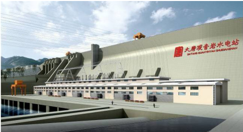
图2 观音岩水电站大坝及发电厂房
