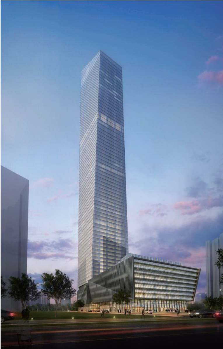
图3 太原市建筑设计研究院项目-摩天桥
