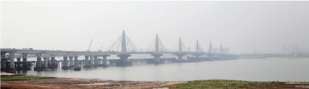
图19 跨江主桥施工期间现场照片
