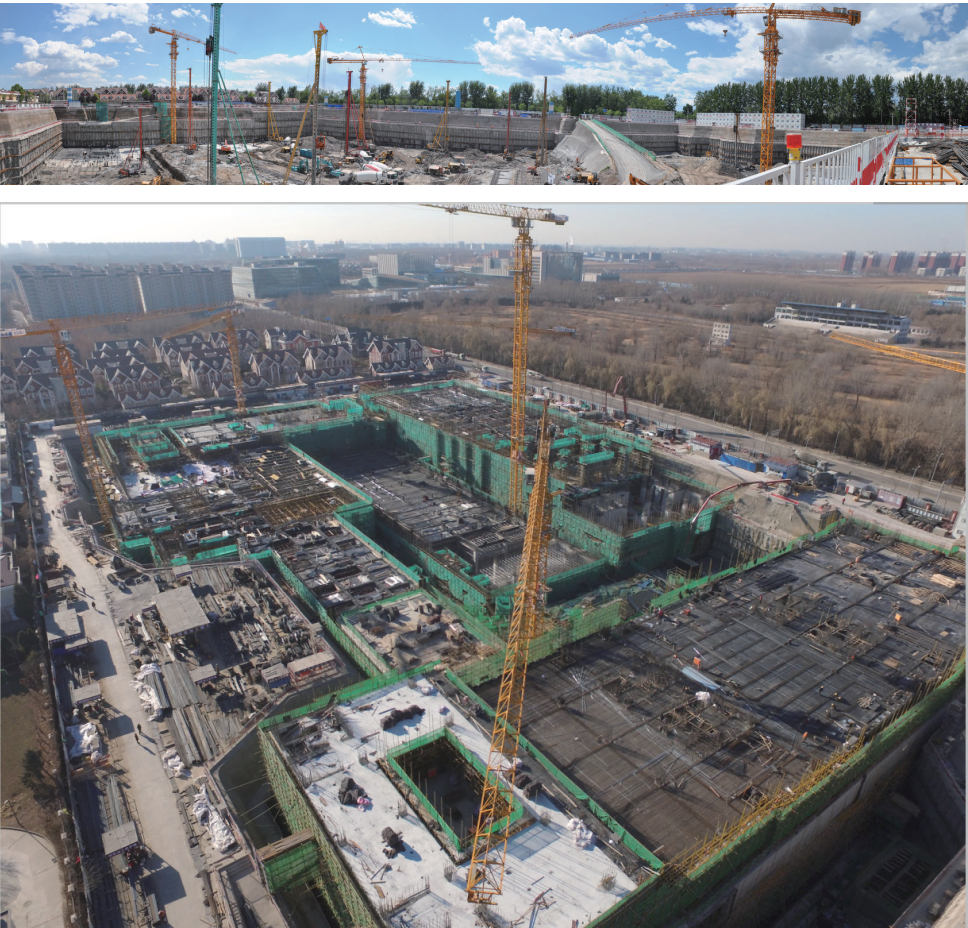
图24 中信银行信息技术研发基地项目施工现场
