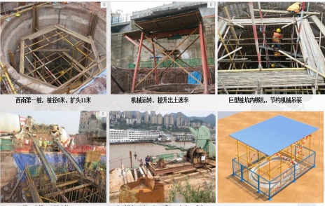
图19 超大超深异形柱施工控制
