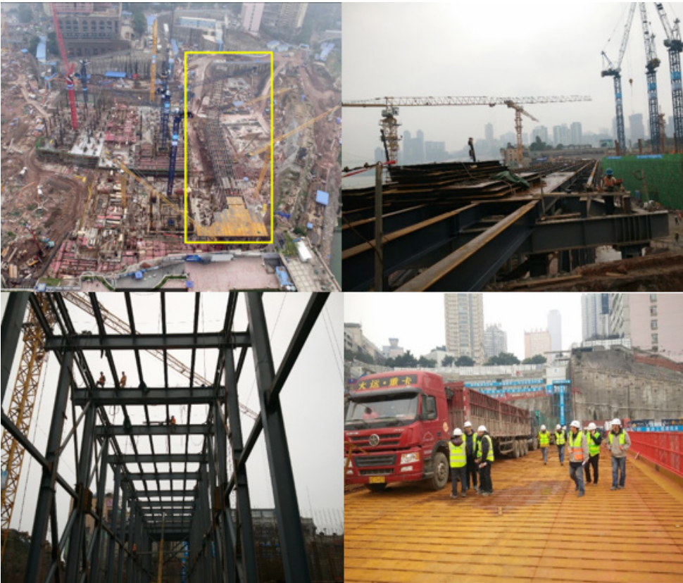
图21 钢栈桥现场施工效果
