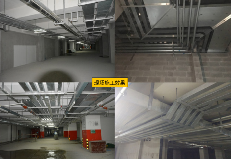
图10 机电深化现场施工效果
