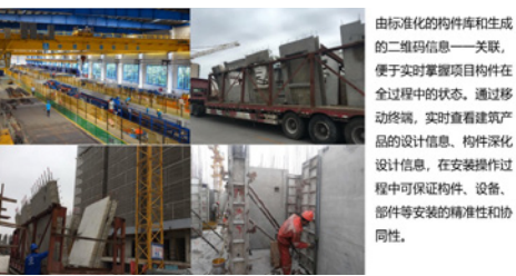
图16 构件的安装次序、定位、误差矫正
