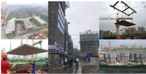
图22 预制构件现场施工装配
