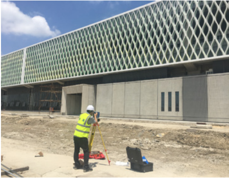
图34 高架车站外立面点云数据获取
