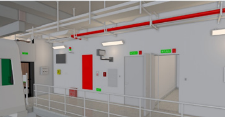
图19 车站端头处箱柜（设备）安装
