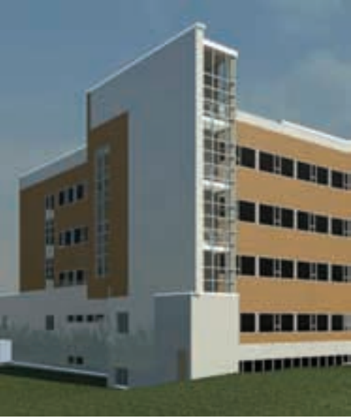
枫树林医院。建筑师：BWBRA建筑师。 机械/电力工程师：Dunham Associates。
