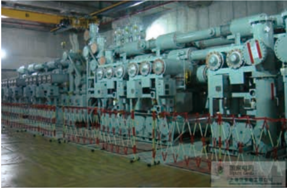
图片由上海送变电工程公司提供。
