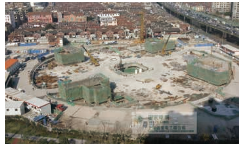
图片由上海送变电工程公司提供。
