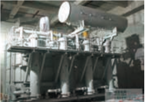
图片由上海送变电工程公司提供。
