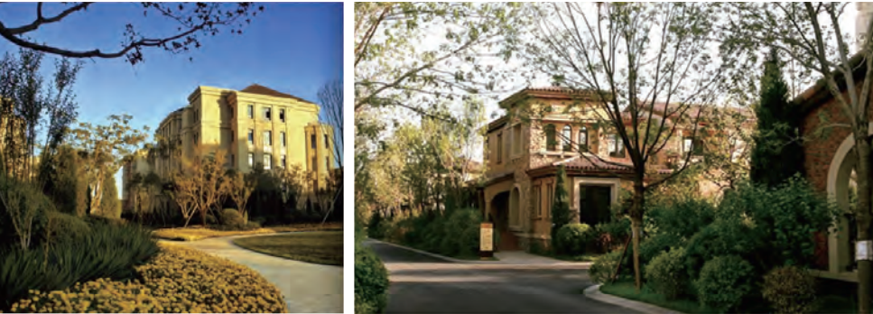
图1 实拍一期工程现场
