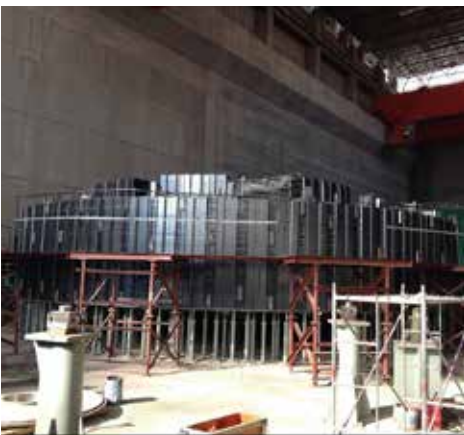
图11 最新现场施工图片
