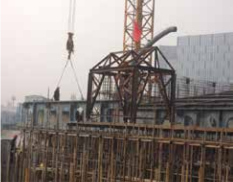
图12 钢结构滑移安装现场图片
