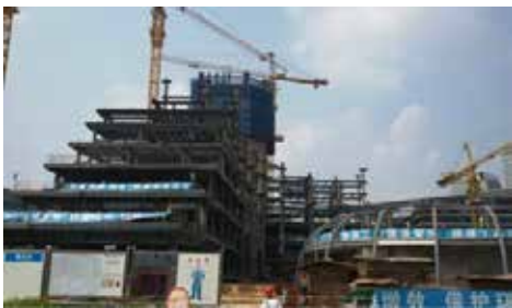
图9 施工进度模拟与实际进度对比图
