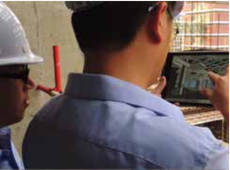
图8 施工指导及现场产品检验
