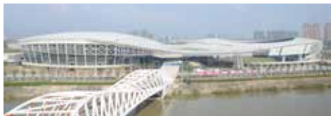
图3 现场施工过程远景实物图
