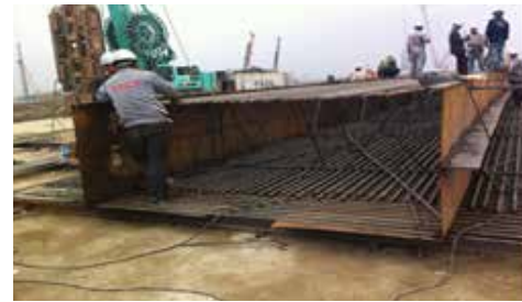
图9 现场钢筋加工
