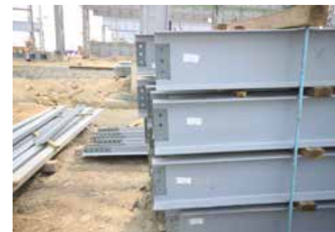
图22 现场钢结构跟踪标签
