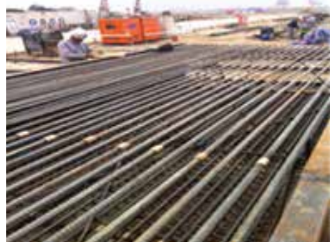
图8下 钢厂柱基础钢筋模型
