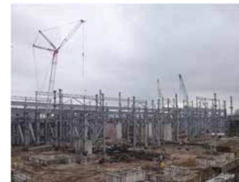
图24 现场钢结构安装
