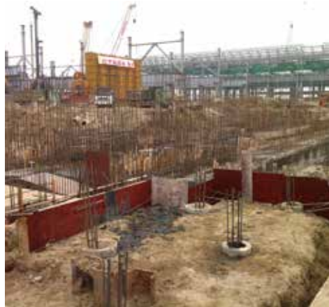
图6下 1#2#板坯连铸机基础开挖现场
