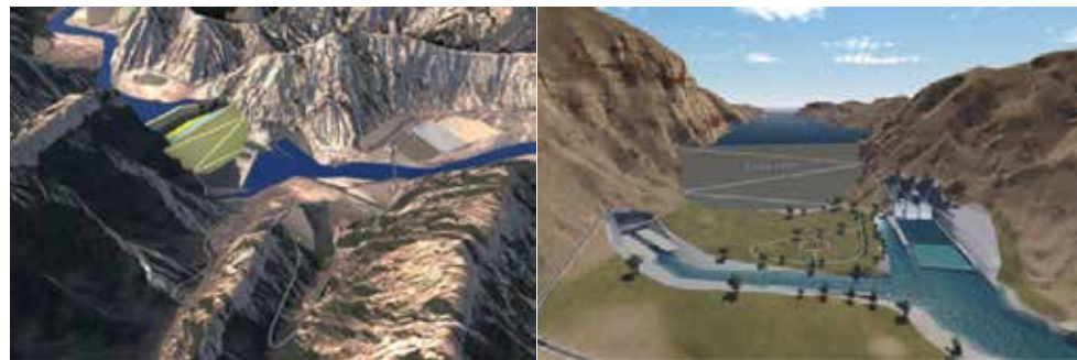
图1 阿尔塔什水利枢纽工程枢纽区布置鸟瞰图
