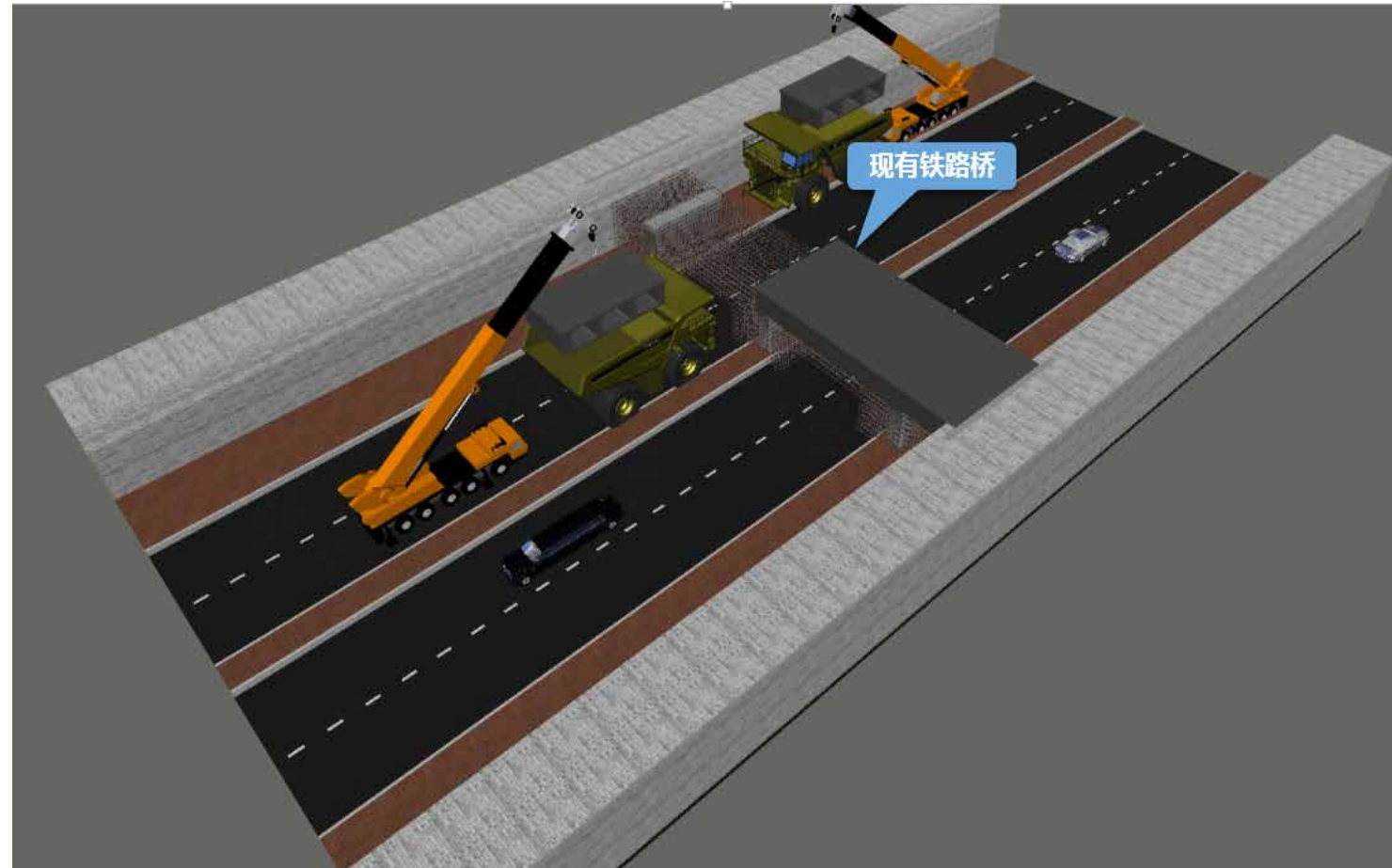
图7 桥梁拆除施工过程
