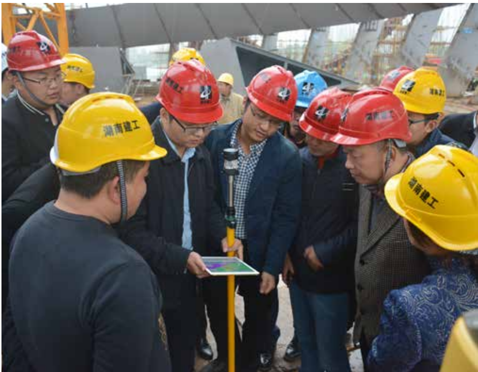
图18 施工现场照片
