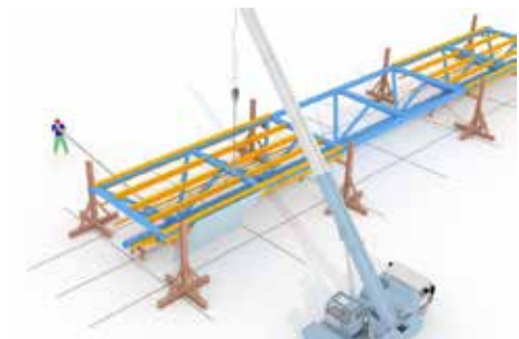
图15 三角钢桁架地面拼装
