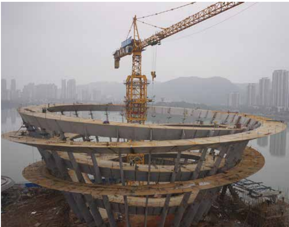
图19 施工现场航拍图
