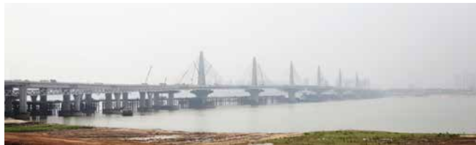
图19 跨江主桥施工期间现场照片
