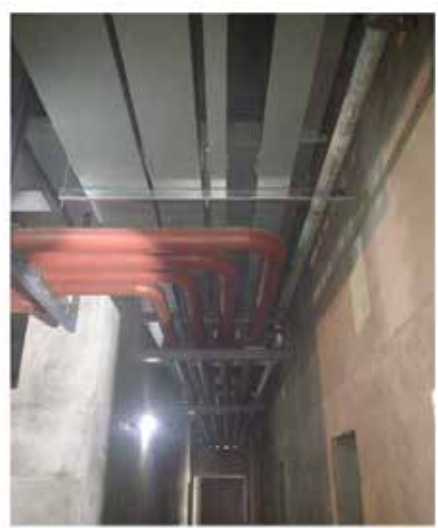
现场施工照片
