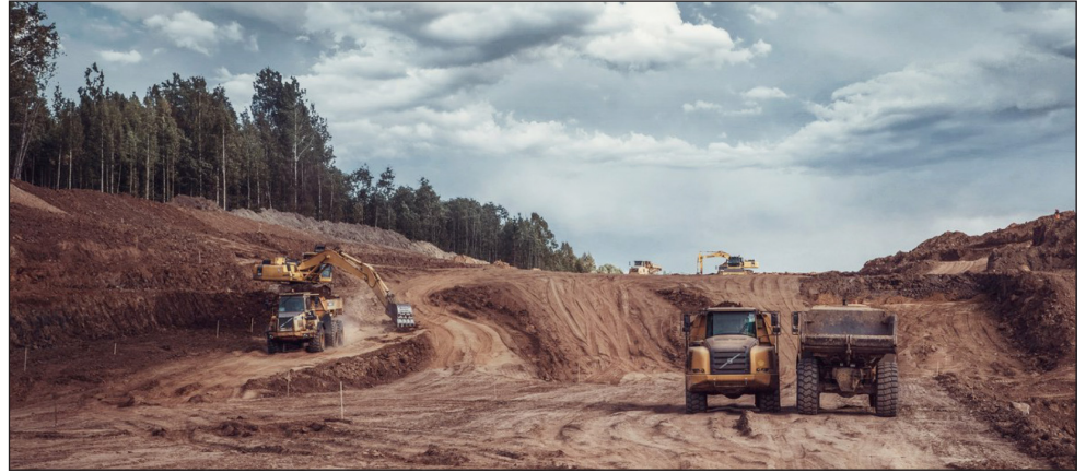
Строительство ЦКАД-4. Изображение предоставлено ГК «Автобан».
