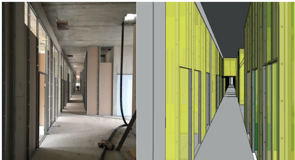
Hopital d'Ajaccio - Circulation en cours de montage
