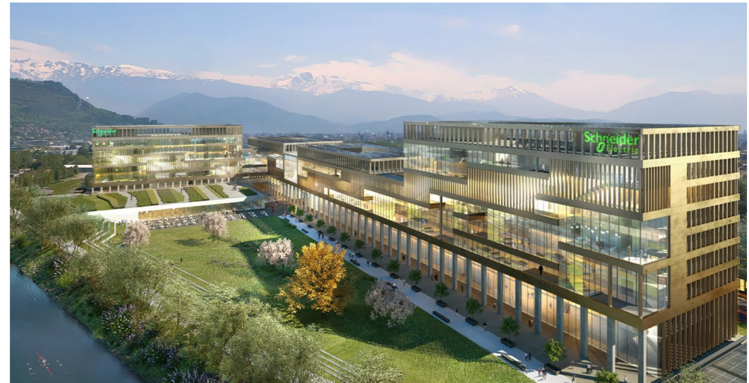
Schneider Electric IntenCity. 25 000 m 2 ; Lauréat du concours en 2015. Chantier en cours. Remerciements : Schneider Electric. © Groupe-6. Vidéo : https://vimeo.com/294738454
