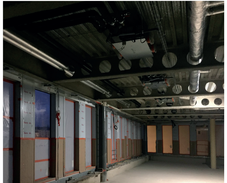
Installation des Ventilo-convecteurs sur les plateaux de bureaux. Crédit photo Groupe BALAS.
