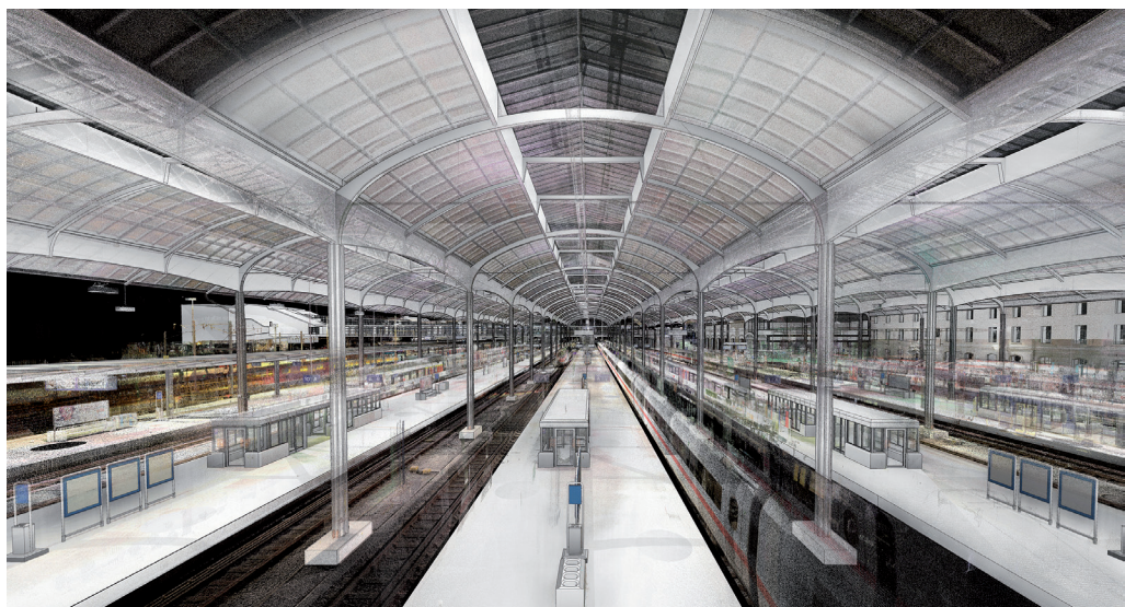
Innere der fünfgliedrigen Bahnhofhalle des Bahnhofs Basel SBB. © BIM Facility AG
