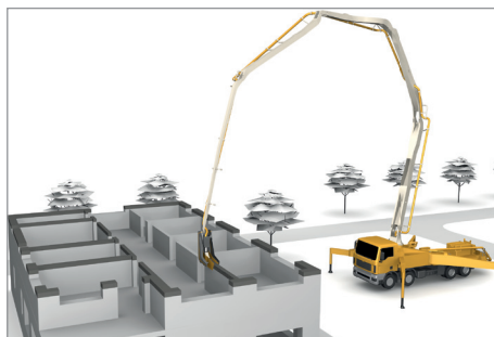
Betondruck auf der Baustelle mit CONPrint3D® © TU Dresden
