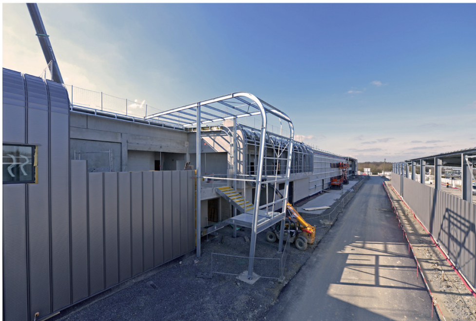
Garage Atelier du Métro de Rennes : chantier en cours. Crédit photo - Willy Berré
