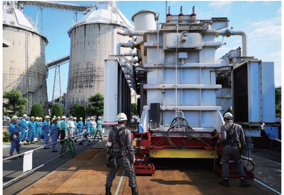
北日本重量が開発した重量物移動装置「アタッチメント式移動装置 Zero3」
