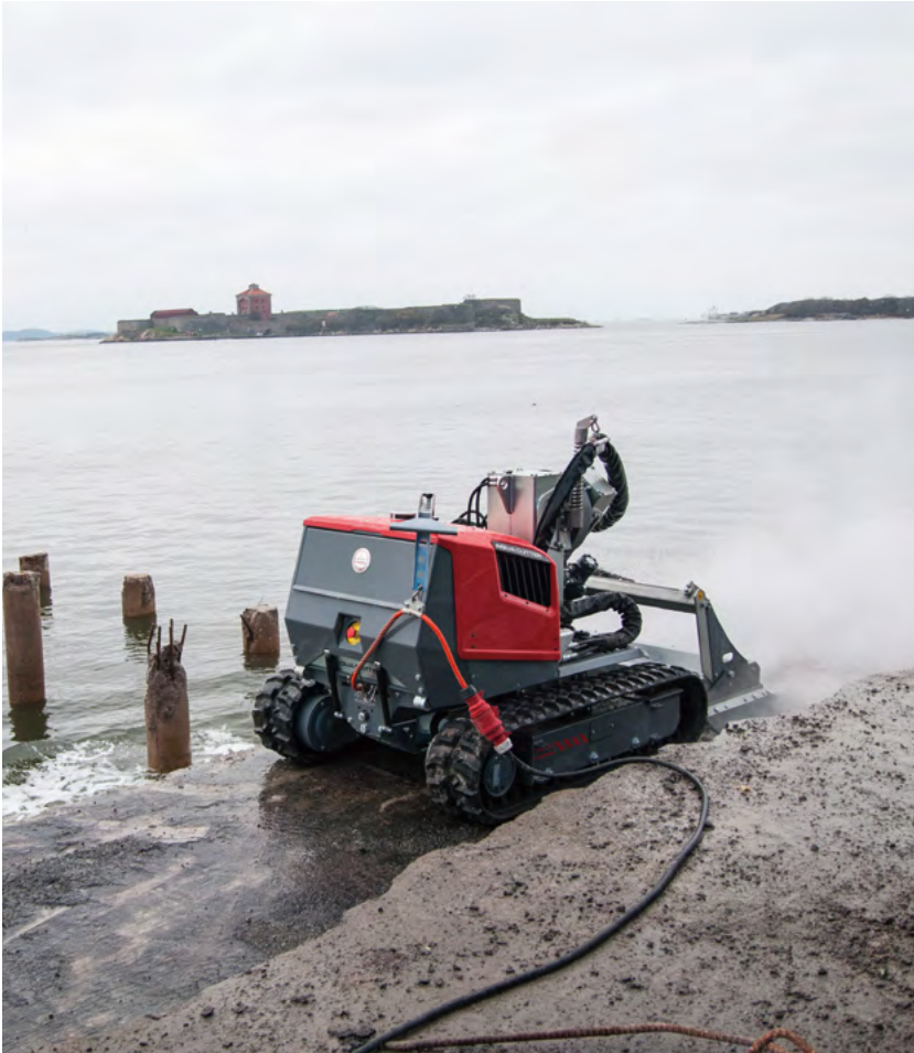
ヨーテボリ港の停泊場で稼働中の Aquajet Systems 社のハイドロデモリション ロボット。
