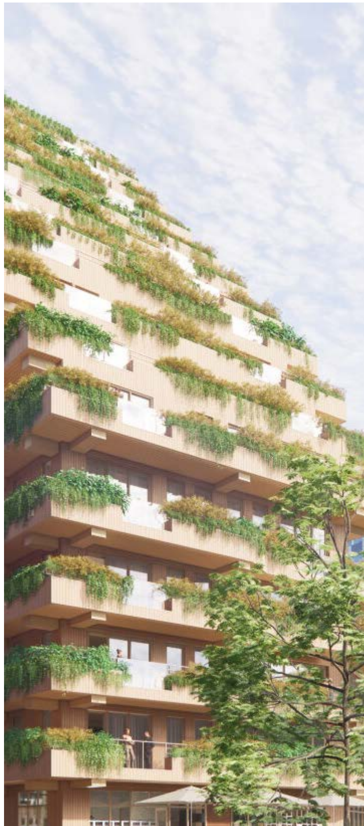
SAWA, zaprojektowany przez Mei „najzdrowszy budynek w Holandii” i pierwszy drewniany wieżowiec mieszkalny w Rotterdamie, wykorzystuje w szerokim zakresie drewno klejone krzyżowo (CLT). Zdjęcie dzięki uprzejmości Mei
