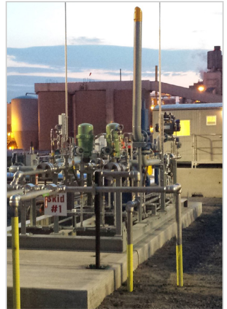
画像提供：Process Pipeline Services 社
